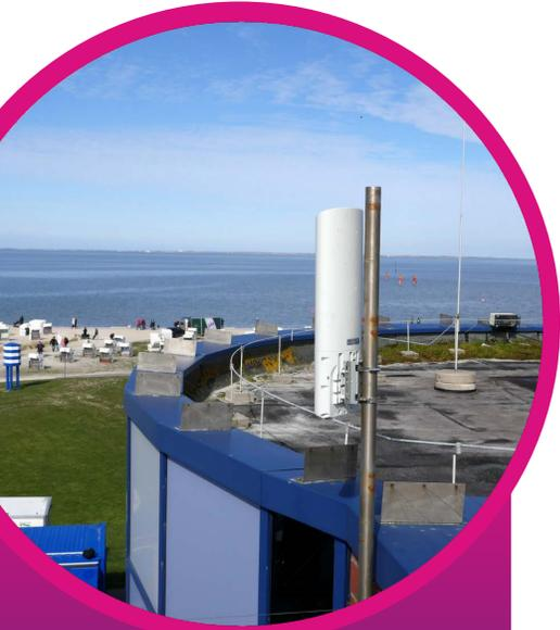
Entlang der Promenade wurden sechs WLAN Outdoor Access Points sowie drei 60-GHz-Richtfunk-Komponenten installiert. Diese Lösungen halten auch den widrigsten Umgebungsbedingungen stand und sorgen verlässlich für drahtlose Gigabit-Konnektivität.
